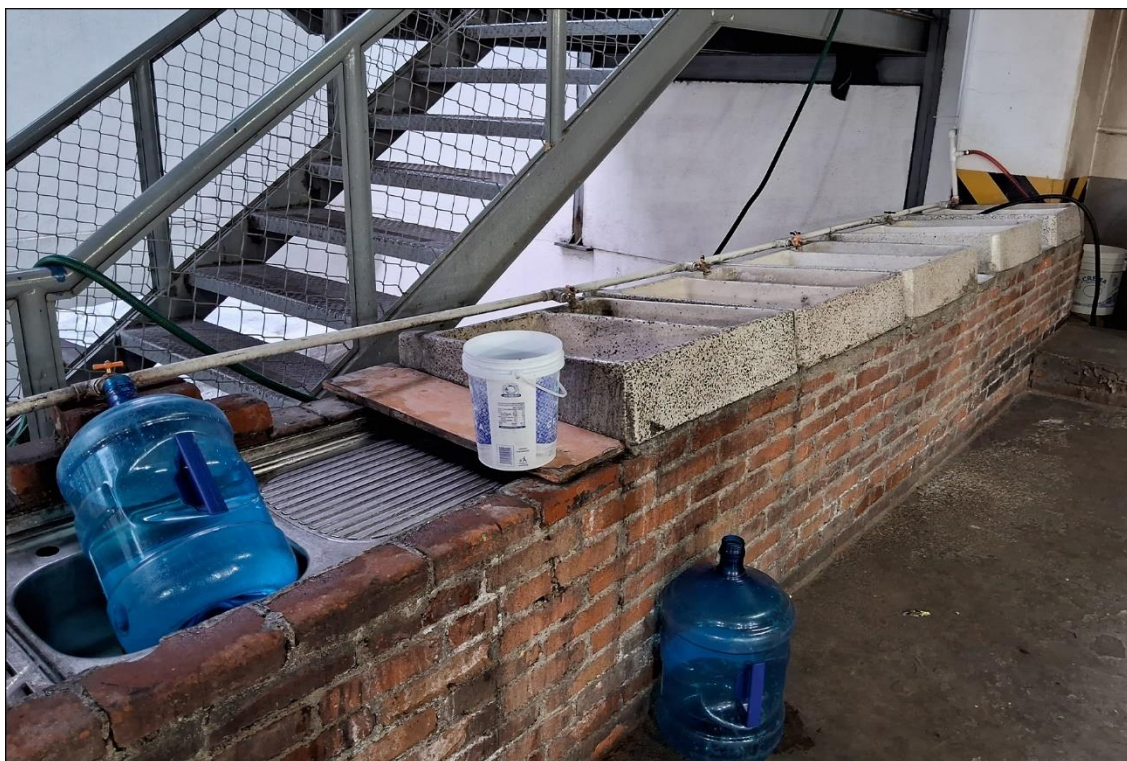
Figura 33. Lavabos construidos en la cocina comunitaria
